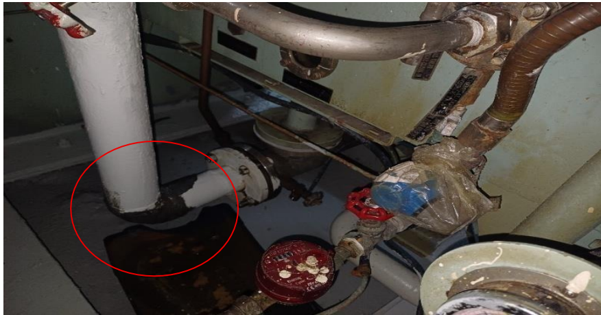
Gambar 1. Pipa air laut terjadi kebocoran akibat korosi
