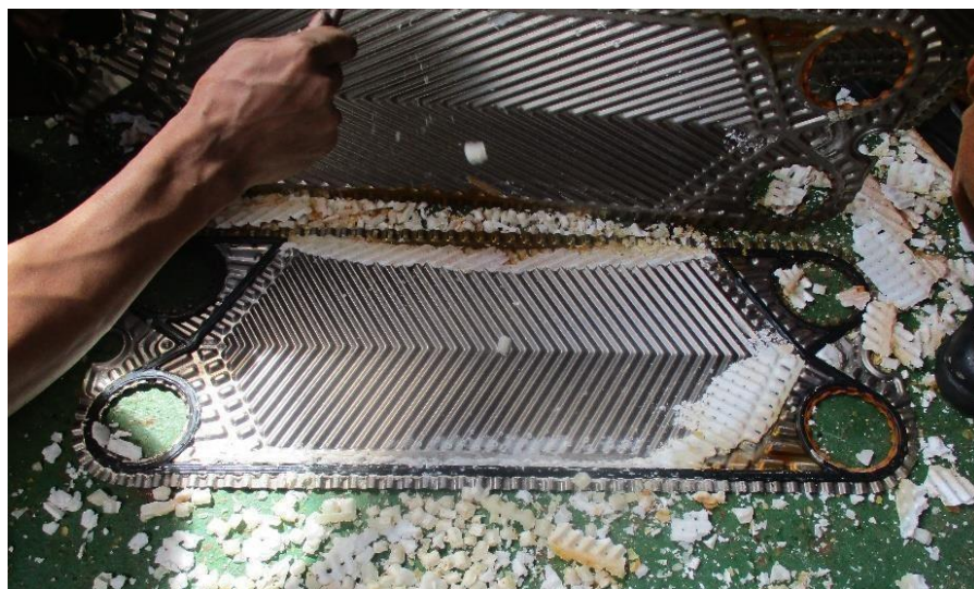
Gambar 2. Pelat evaporator yang kotor
