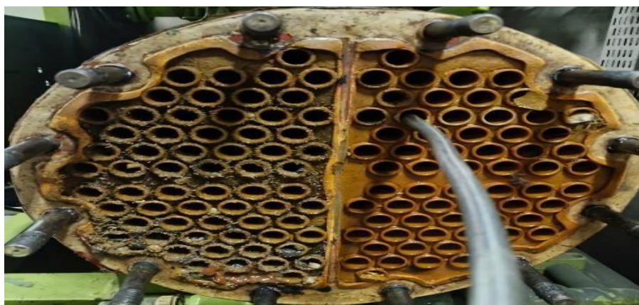
Gambar 2. Kondensor sebelum dibersihkan
